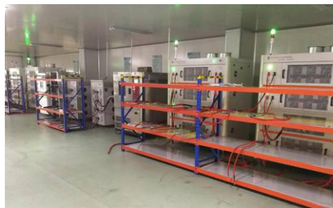
电性能实验室 Electrical performance lab
